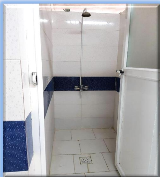
حمام خوابگاه ۱ دبیرستان بعد از اجرا
