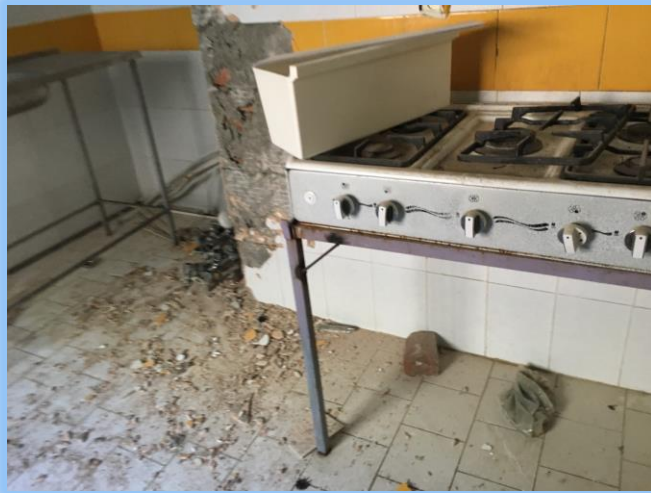
آشپزخانه قبل از اجرا
