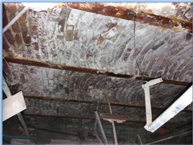
پوسیدگی سقف سرویس های بهداشتی
