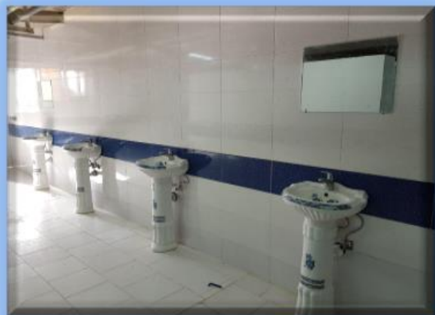
سرویس های بهداشتی بعد از اجرا
