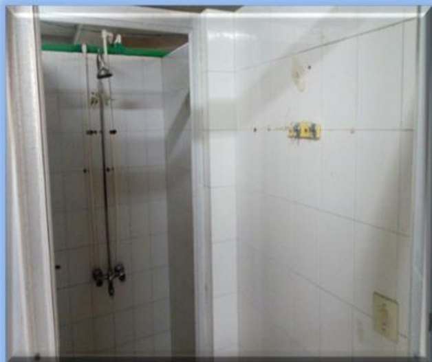
حمام خوابگاه ۱ دبیرستان قبل از اجرا
