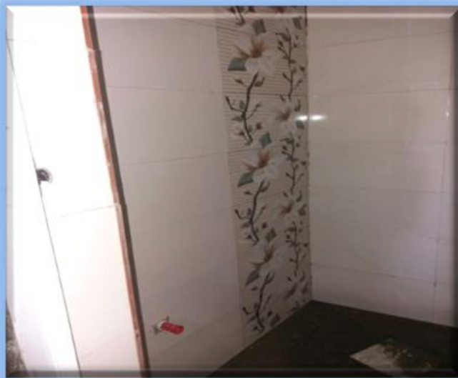
سرویس های بهداشتی بعد از اجرا
