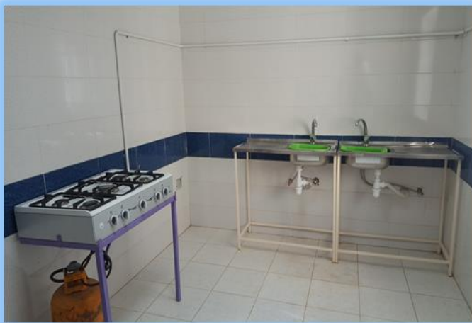
آشپزخانه بعد از اجرا
