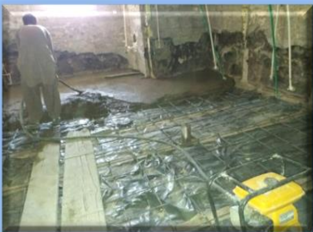
اجرای سقف کامپوزیت
