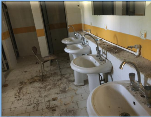
سرویس های بهداشتی قبل از اجرا
