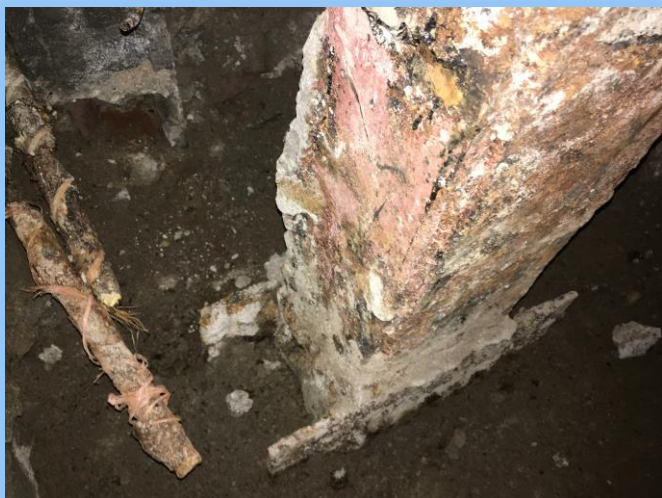
پوسیدگی ستون به دلیل نشتی آب
