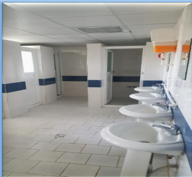
سرویس های بهداشتی بعد از اجرا
