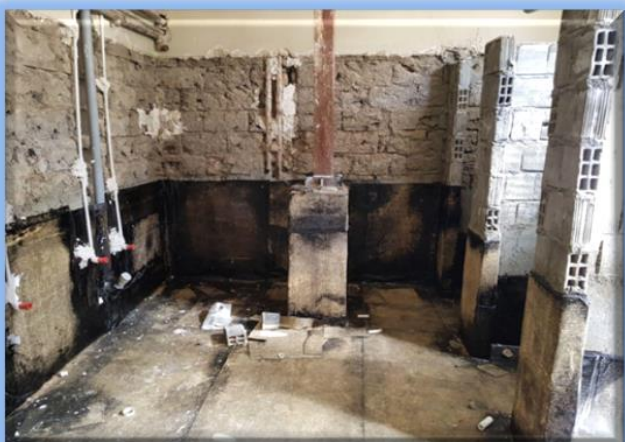
مقاوم سازی ستون در حین اجرا
