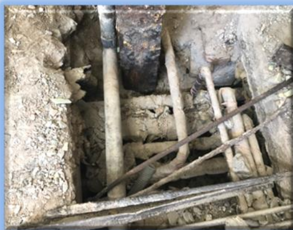
پوسیدگی ستون به علت مجاورت با کانال تاسیسات
