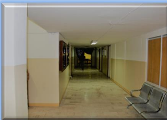
رنگ آمیزی قسمت اداری مجموعه ۲۲ بهمن بعد از اجرا
