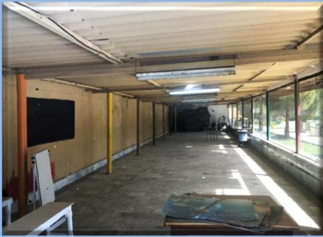
سالن تندرستی حجاب قبل از اجرا
