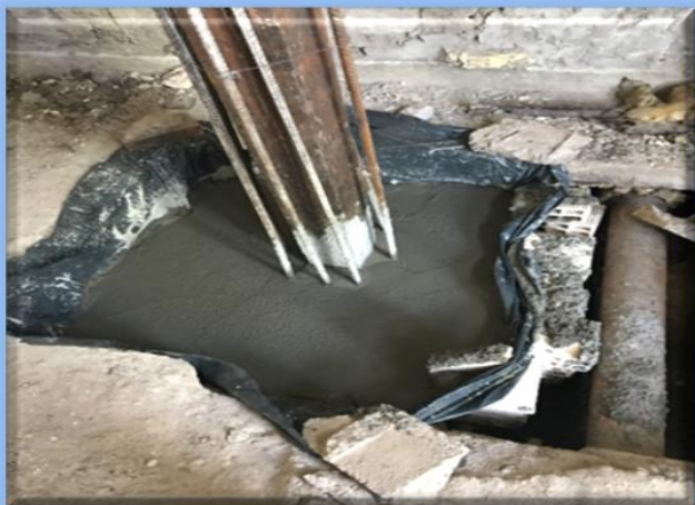
مقاوم سازی ستون در حین اجرا
