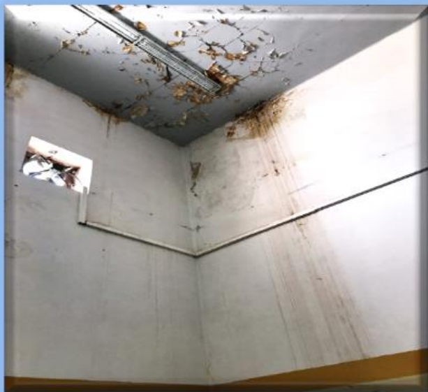
سالن بدنسازی قبل از اجرا
