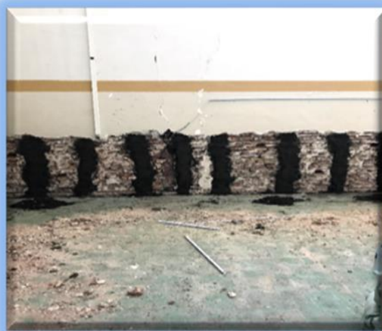
اندود سیمان با چسب بتن و پودر آب بند در حین اجرا
