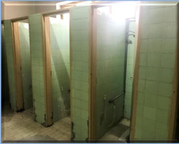
سرویسهای بهداشتی قبل از اجرا
