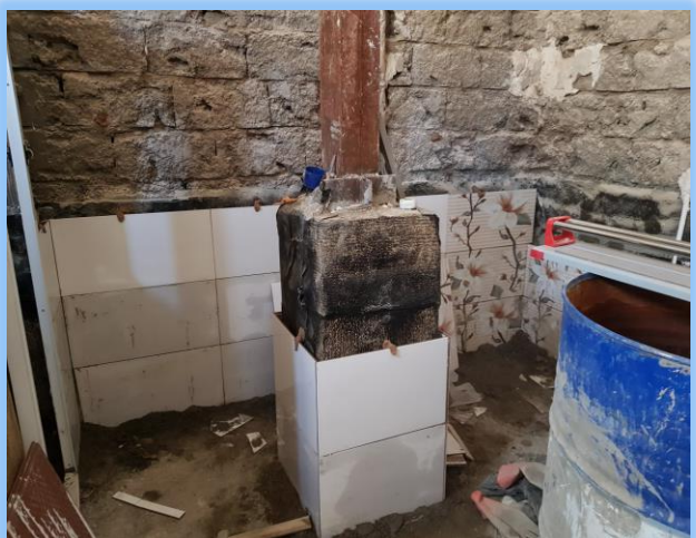
مقاوم سازی ستون در حین اجرا
