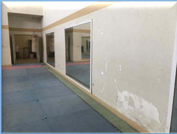
سالن بدنسازی قبل از اجرا
