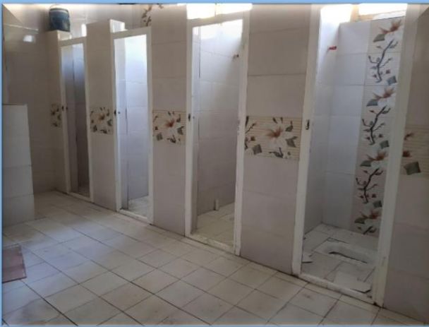
سرویسهای بهداشتی بعد از اجرا
