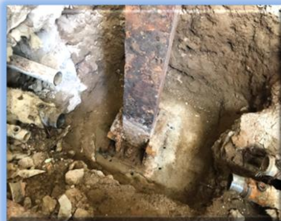
حذف لوله های تاسیساتی جهت تقویت ستون
